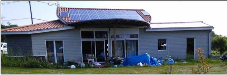
ler l'hygrométrie de la maison, d'assurer une masse (inertie thermique mesurée de 30 heures), de chauffer la maison (mur chauffant grâce à un serpentín en tuyau PER que nous avons passé dans le mur au fur et à mesure de sa construction). La sensation de chaleur
