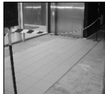
Pose du carrelage hall entrée Enib
