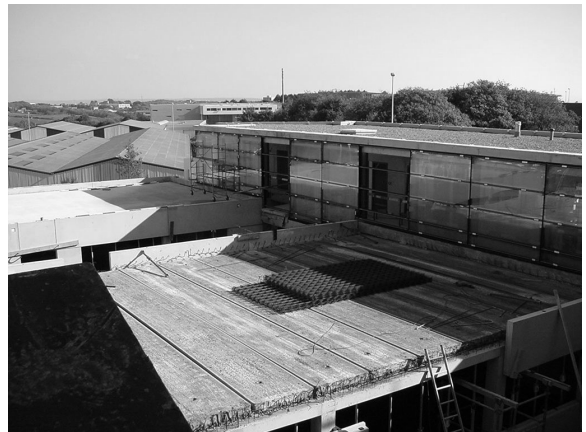
28/10/2003, photo prise du toit du CERV, avec extension de l'Enib.
