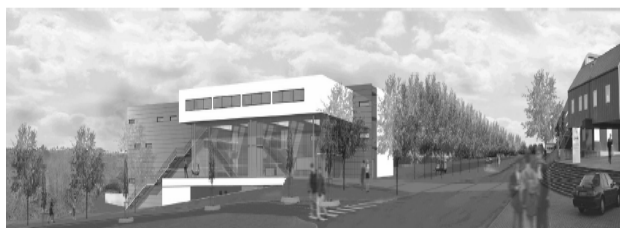
L'ouvrage achevé. (Photo Michel Quéré)
