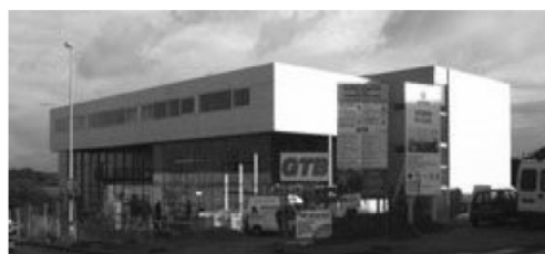
Le chantier de l'extension au 30/10/03
